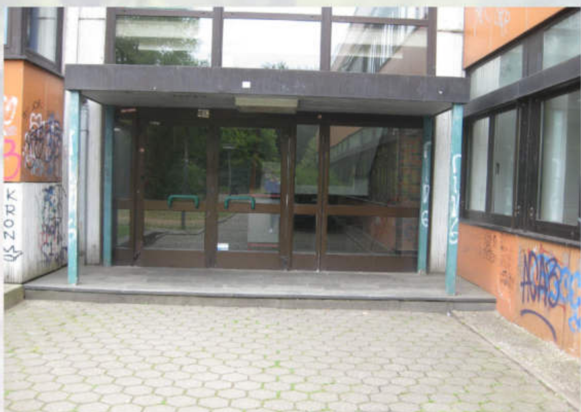
NEBENEINGANG BT A/B HAUPTTREPPEHAUS
