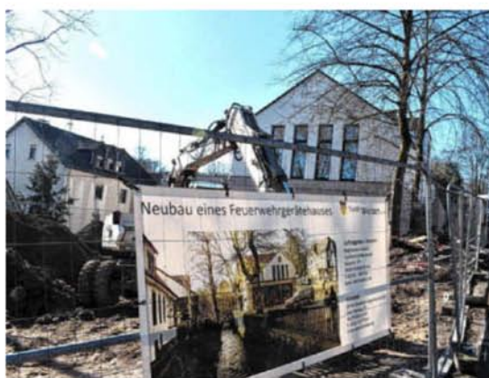
Visualisierung und Baufortschritt kommen sich immer näher: Die neue Feuerwache in Wengern steht vor der Fertigstellung.
