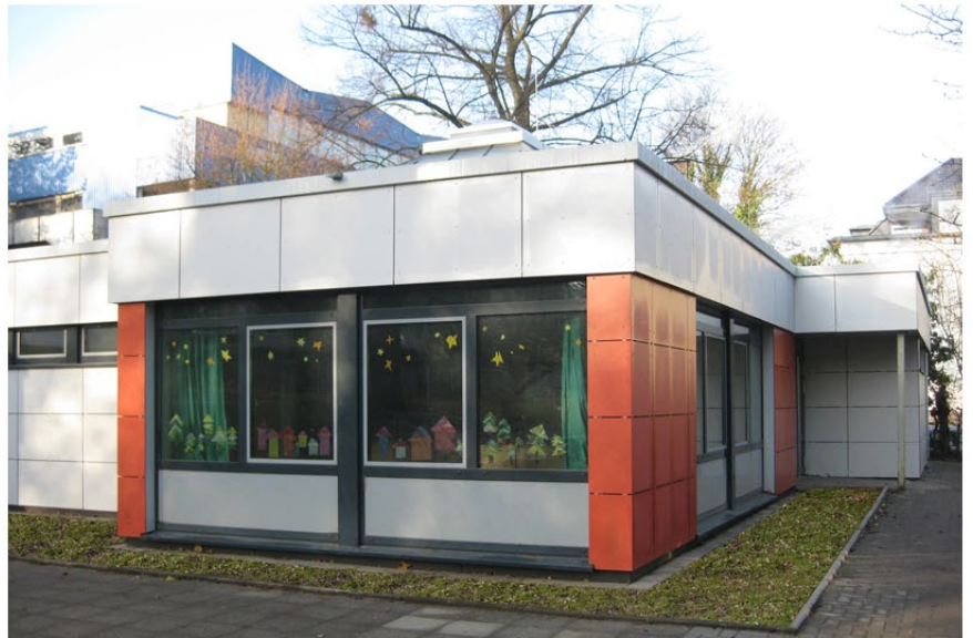
Ansicht von Osten
