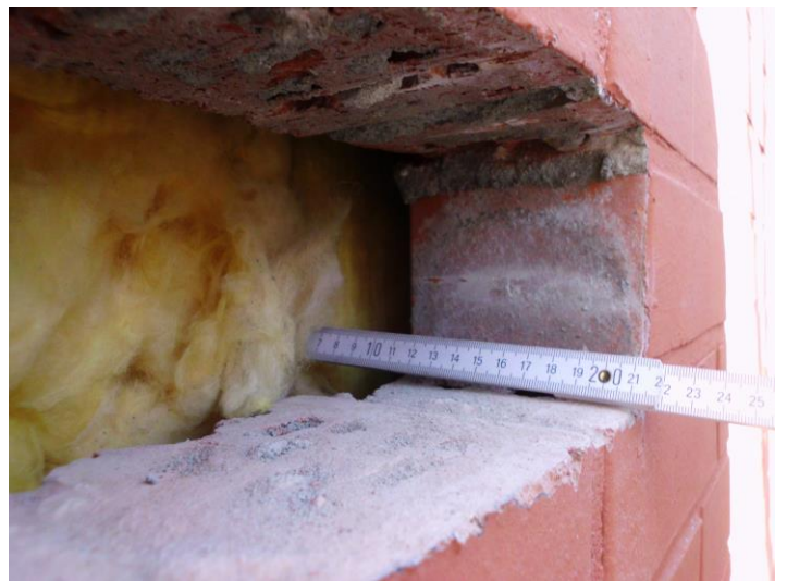
Bauteilöffnung – 2-schaliges Mauerwerk
