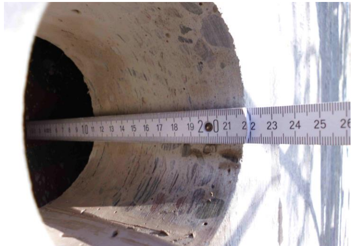
Bauteilöffnung – Betonfertigteilelemente
