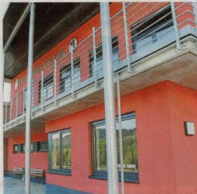
Das neue Esloher Feuerwehrhaus wird am 3. September offiziell eingeweiht. Foto: Lena Blome
