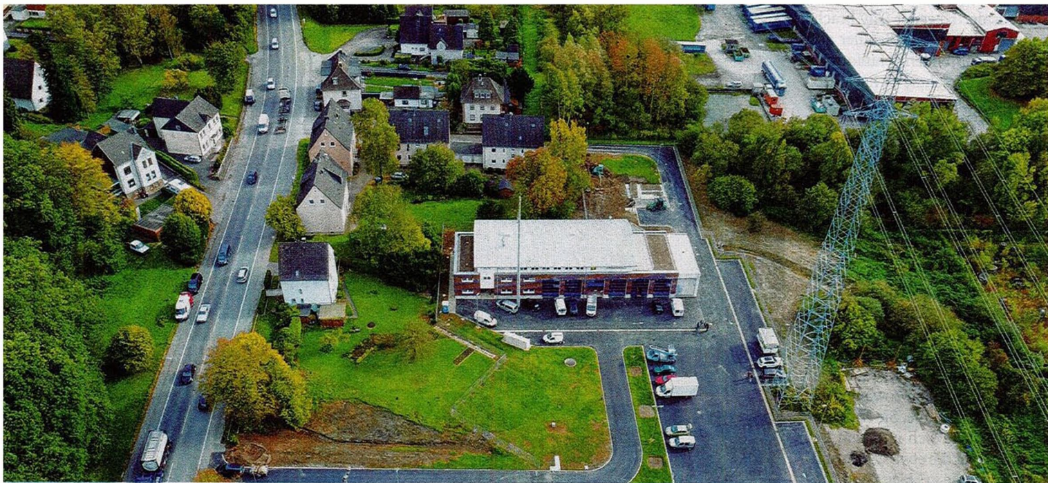
Das neue Gerätehaus für Berchum und Garenfeld aus der Luft: Das Gebäude steht an der Verbandsstraße auf der ehemaligen Fläche des Sportplatzes Berchum. Es hat sechs Abstellhallen und mehrere Funktions- und Verwaltungsräume. Heute wird es eröffnet.
