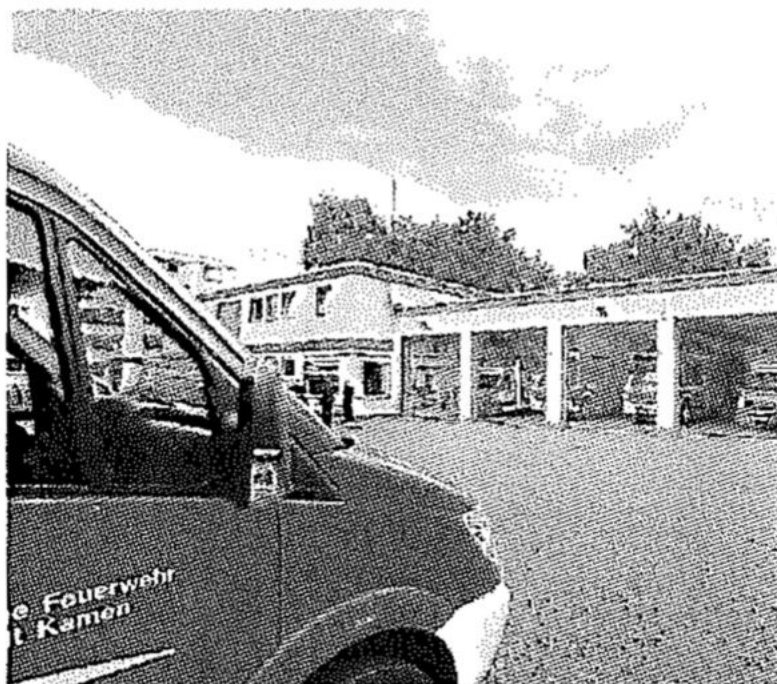
Derzeit teilen sich Feuer- und Rettungswache die Garagen für Feuerwehrfahrzeuge und Rettungswagen. FOTO MILK
