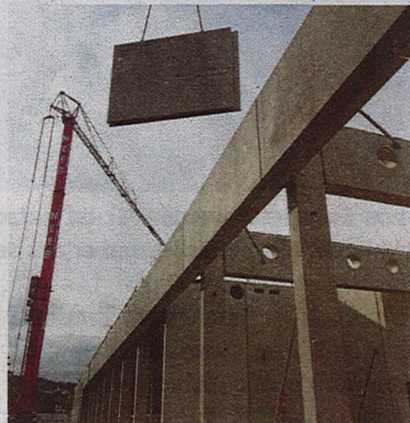
15 Tonnen ist ein Wandfertigteilschwer.
