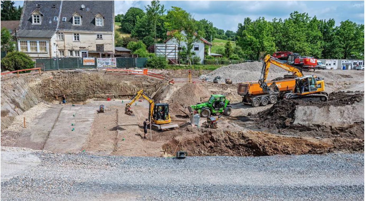
Die Baustelle im Juni. Foto: Stadt Wuppertal
